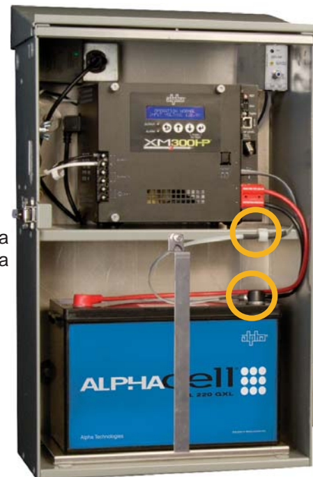
Fig. 1-8, Puntos de ubicación de la sonda de temperatura
